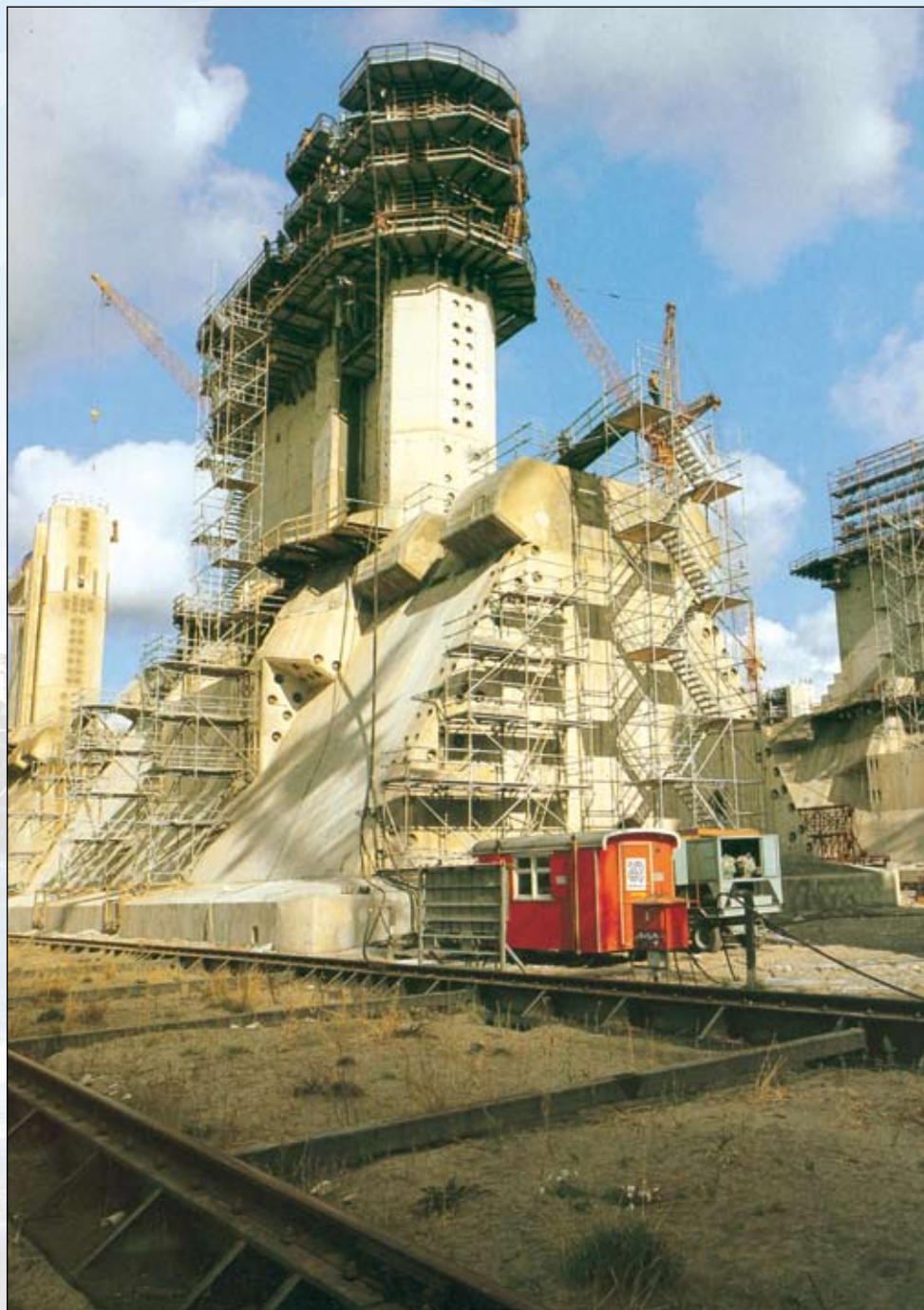
De bouw van een pijler
