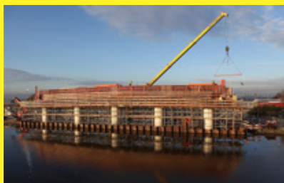
Viaduct van de Westrandweg in aanbouw
