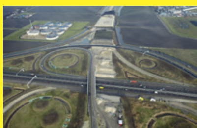
Werkzaamheden knooppunt Raasdorp
