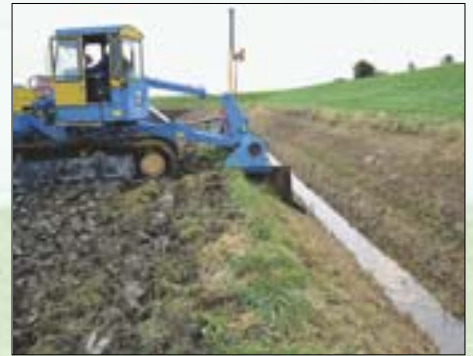
Door nieuwe drains aan te leggen, wordt het risico op wateroverlast als gevolg van een hoger waterpeil aanzienlijk beperkt.
